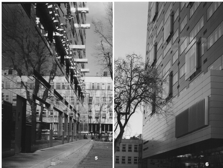
Rys. 5-6. Budynek biurowy Focus w Warszawie (Kuryłowicz & Associates, 2000) (fot. autorka)
